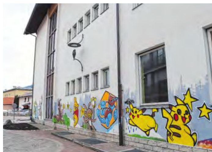
Das alte Schulgebäude der VS am Kirchplatz soll ab 27. Mai abgerissen werden. Der beengte Bauplatz verlangt den Planern alles ab.
